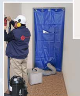
FILTRO en een speciaal deuropening-gordijn zorgen in kleine ruimten voor het afvangen van zweefstof.
